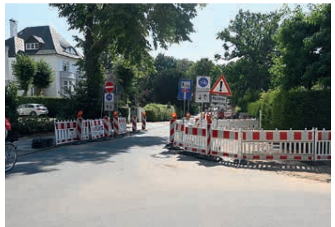
Die Sperrung in der Parkstraße soll noch bis zum 31.12.2022 andauern.
